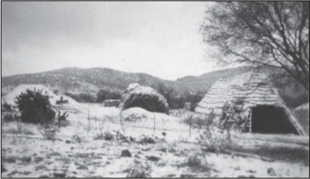
Figuur 3: Spardak of kapstyl-veewagterskuiling in die winter van 1962 op die plaas Helena (Bron: Jansen van Rensburg, Helena 2012.11.24)
